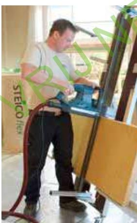
Kwaliteit merkt men al bij de verwerking ! STEICOflex 036 beschikt over een dichte, homogene vezelstructuur. Daardoor zijn de isolatiematten bijzonder stabiel en klevend. Ze behouden hun vorm en blijven permanent op hun plaats in de compartimenten waar ze verbouwd worden.
