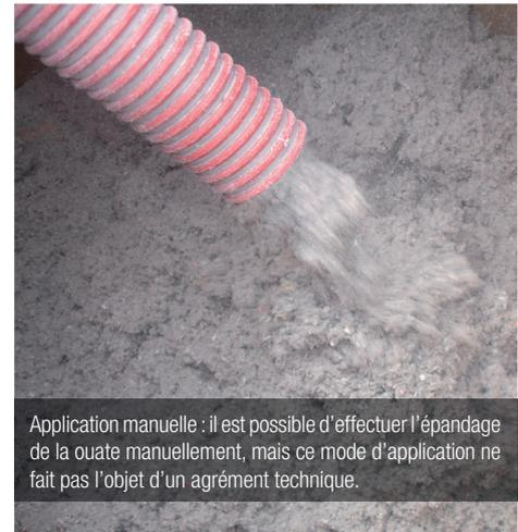
Application manuelle : il est possible d'effectuer l'épandage de la ouate manuellement, mais ce mode d'application ne fait pas l'objet d'un agrément technique.
