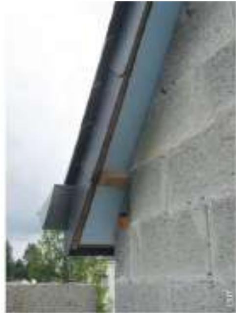
Verbindung zum seitlichen Dach eines Daches mit Schrägen (Blick auf die Dämmung vor den Fassadenarbeiten)
