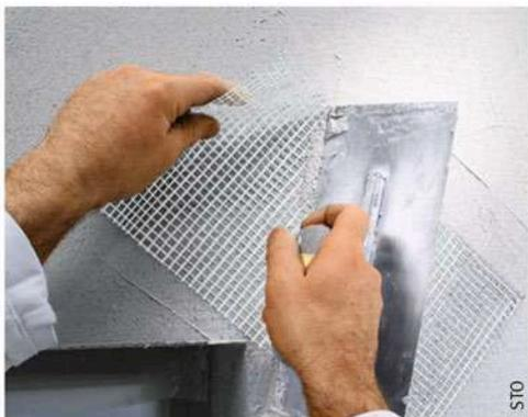
Verlegen eines Verstärkungsnetzes Adam Matériaux in die Ecke eines 300X300 mm-Schachts (MOUCHOIRS)
