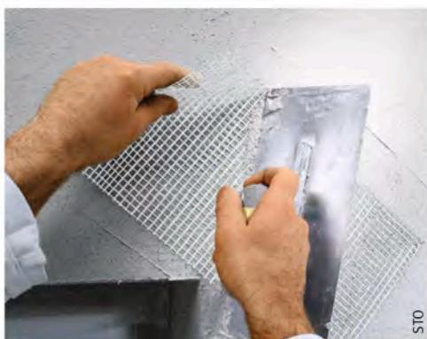
Pose d'un filet d'armature Adam Matériaux de renfort dans l'angle d'une baie 300X300mm (MOUCHOIRS)
