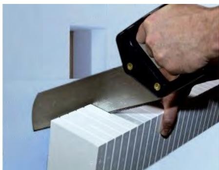
Couper un cube de 10x10cm et fixer-le dans l'EPS à l'aide de mousse PUR Adam Matériaux avant l'application de la colle grise d'enduisage Adam Matériaux. Marquer le cube avec une vis pour retrouver le cube, pour la fixation de l'objet, après la pose du crépis Adam Matériaux
